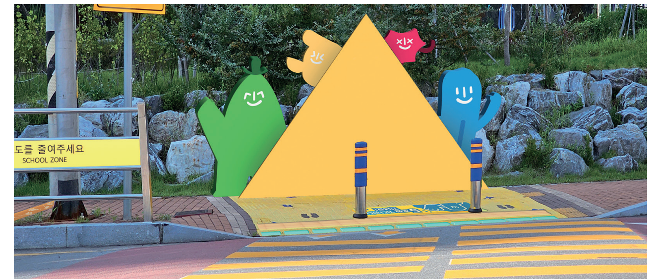
물금초 후문 횡단보도에 옐로카펫을 보강하고 양쪽에 캐릭터 갈바를 설치해 인지성을 더욱 높였다.
